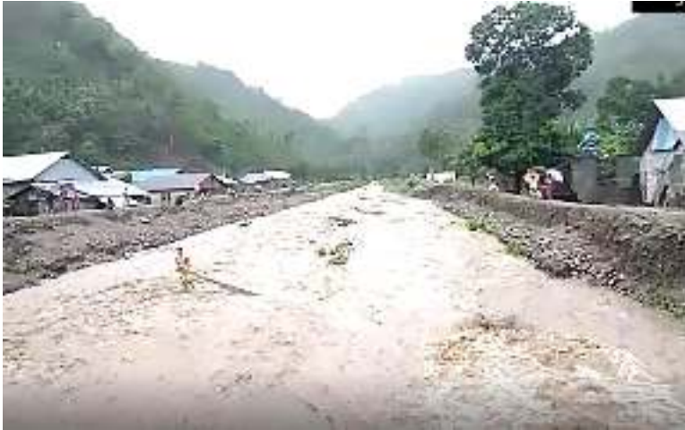
Gambar 4. Banjir kecil pada tanggal 25 Maret 2016 sore hari pada kondisi hujan ringan, tampak dasar sungai sudah naik dan dinding tanggul mulai terkikis. Foto diambil dari video yang diambil oleh Adi Putri dari atas jembatan Nasiri. Dari rekaman video yang sama, capture semacam dimuat di Primahessa, 2017.
