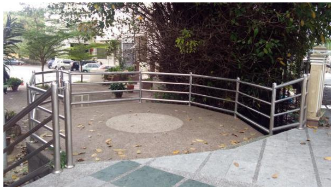
Rajah 7: Pemasangan Jeriji
